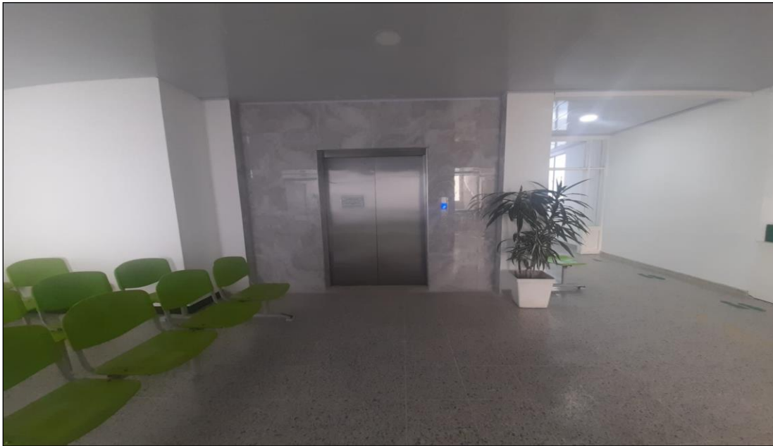
Imagen 12 Ascensor en funcionamiento año 2021
