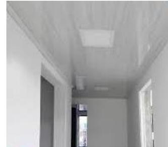
Se refiere esta actividad al Suministro, transporte e instalación de cielos raso con tablilla en pvc color blanco. Incluye: cornisas o molduras en pvc, perfilera de aluminio para soporte, chazos, tornillos, cintas de unión o ensamble entre elementos, cortes y filetes. El acabado inferior será color blanco y debe ser aprobado por la Interventoría.
